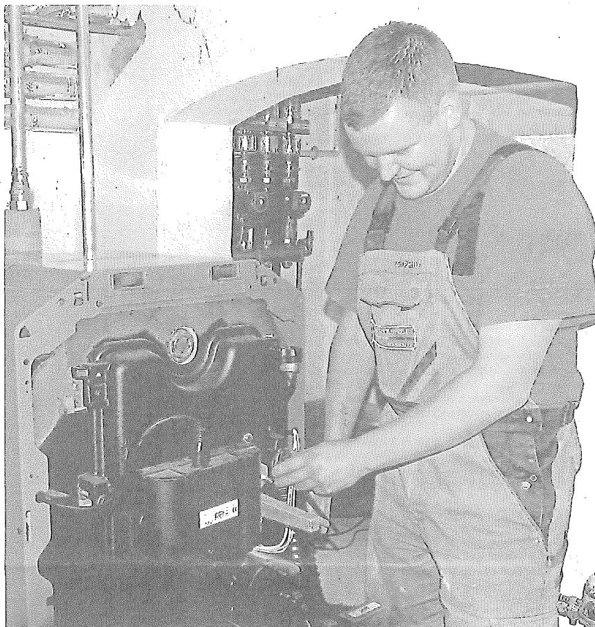
Glenn Pettke vom Schenkendöberner Unternehmen Gellert & Meitzner installiert einen neuen Ölkessel. Das Objekt in Groß Gastrose gehört zu den Immobilien, die die Rivag von der Gemeinde gekauft hat.
