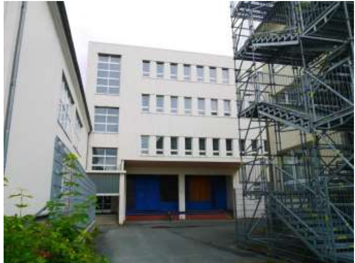
08 Produktions-/ Sozialgebäude Südansicht
