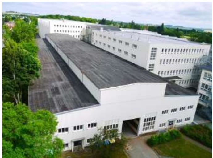
07 Produktionsgebäude Schrägansicht von Süden
