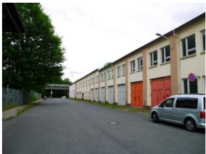
05 Bürogebäude mit Garagen Nordwestansicht
