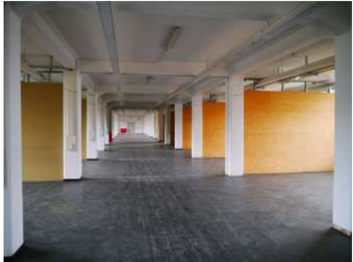
06 Produktionsgebäude OG Innenansicht
