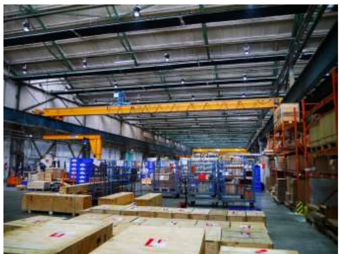
10 Produktions-/ Lagergebäude Innenansicht
