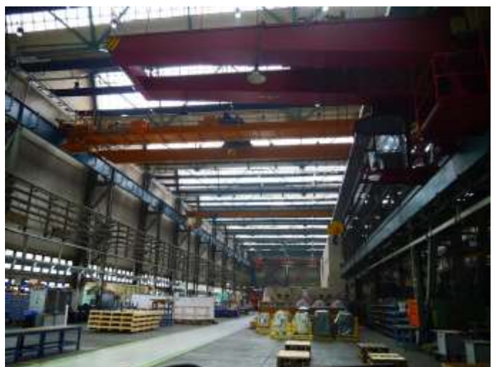
10 Produktions-/ Lagergebäude Innenansicht 10.1
