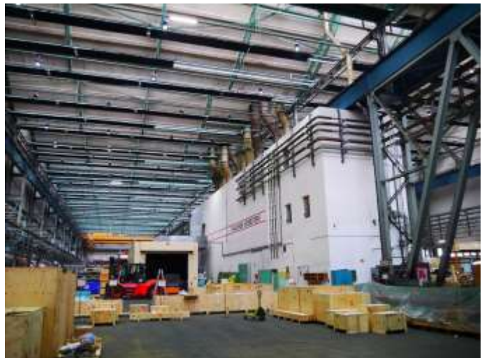
10 Produktions-/ Lagergebäude Innenansicht 10.2
