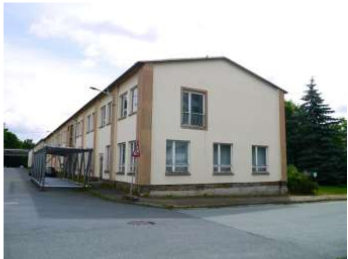
05 Bürogebäude mit Garagen Nordwestansicht
