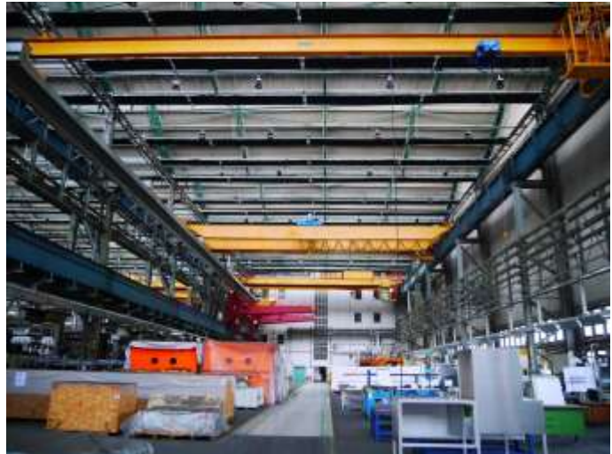
10 Produktions-/ Lagergebäude Innenansicht 10.1
